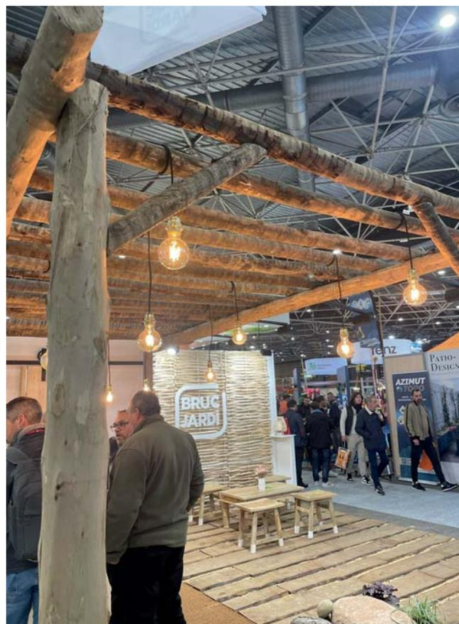
La pérgola de eucalipto está fabricada con un material rústico que presenta imperfecciones características de la madera natural. Cada poste se pela manualmente o con máquina según su diámetro. Son mantenidos deliberadamente en su estado bruto, sin ser cepillados, para conservar un aspecto natural y único. El eucalipto es una madera de densidad moderada, que varía entre 700 y 800 kg/m<sup>3</sup> según el grado de humedad.
